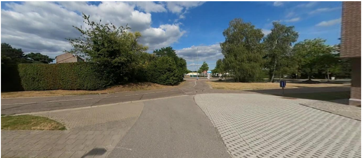
Figuur 11: Ontbrekende fietsinfrastructuur op einde van het fietspad parallel met spoorweg in de Katarinawijk (Nicolai, 2022)
