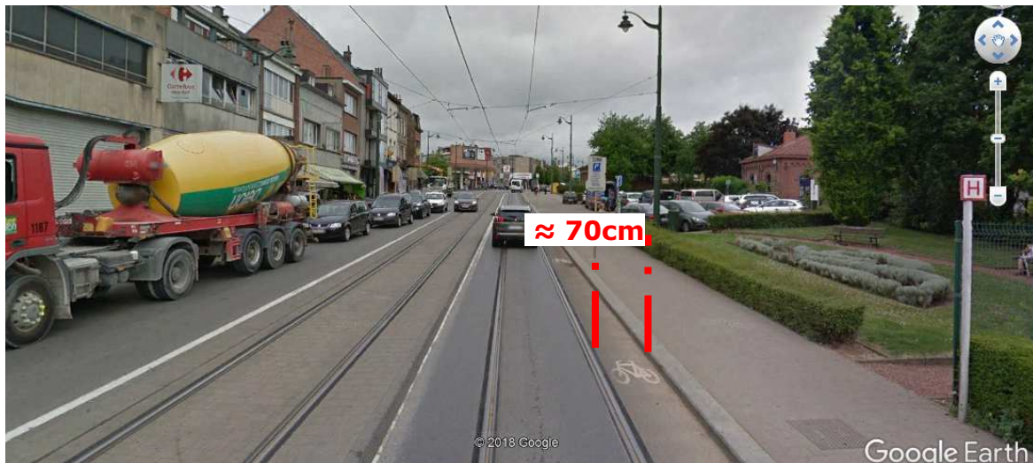
Figuur 45: Steenweg op Gent: onvoldoende effectieve breedte fietspad
